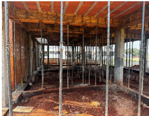
ESTRUTURA CONCRETADA COM ESCORAMENTO E ALVENARIA DE VEDAÇÃO ASSENTADA ENTRE OS PILARES.
