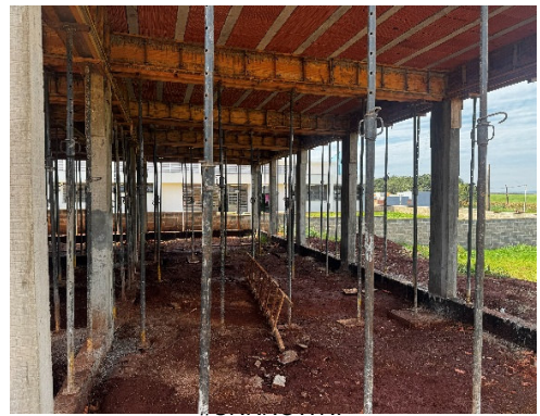
LAJE CONCRETADA E ESCORAMENTO INTERNO; AMBIENTES DEFINIDOS SOB A ESTRUTURA.
