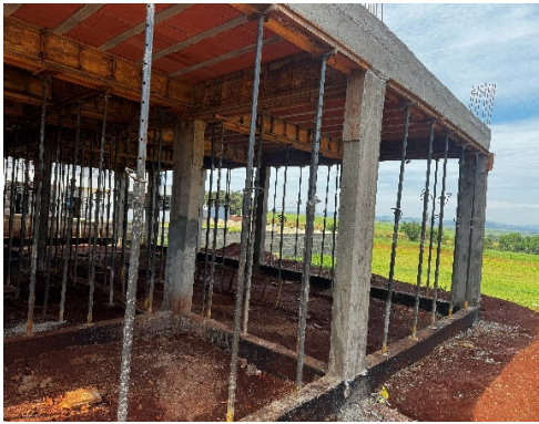
VISTA INFERIOR DA LAJE E VIGAS CONCRETADAS, COM ESCORAMENTO; ALVENARIA DE VEDAÇÃO EM EXECUÇÃO.
