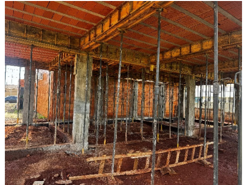
ESTRUTURA CONCRETADA E ALVENARIA DE VEDAÇÃO EXECUTADA/ PILARES.
