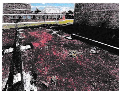
VISTA GERAL - BALDRAMES CONCRETADOS E IMPERMEABILIZADOS
