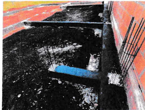
VISTA GERAL - BALDRAMES CONCRETADOS E IMPERMEABILIZADOS
