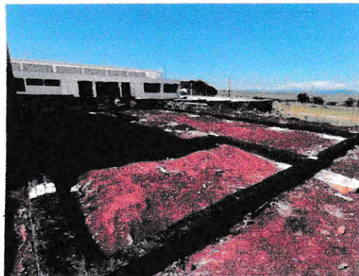
VISTA GERAL - BALDRAMES CONCRETADOS E IMPERMEABILIZADOS
