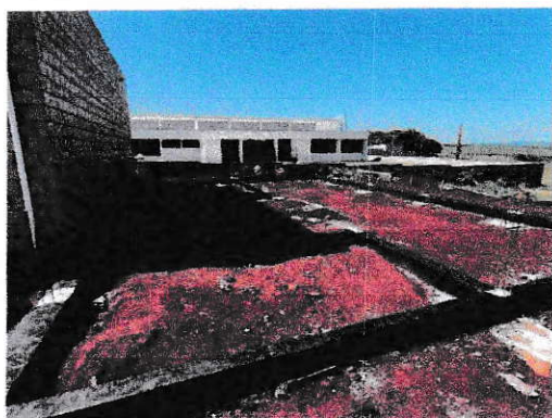
VISTA GERAL - BALDRAMES CONCRETADOS E IMPERMEABILIZADOS
