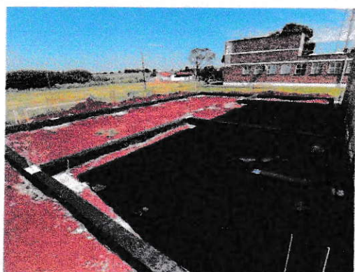
VISTA GERAL - BALDRAMES CONCRETADOS E IMPERMEABILIZADOS
