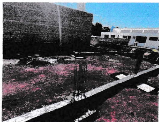
VISTA GERAL - BALDRAMES CONCRETADOS E IMPERMEABILIZADOS
