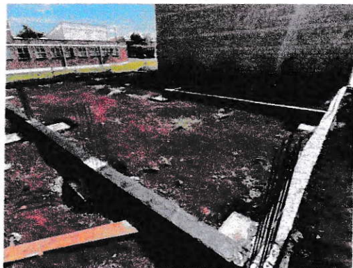
VISTA GERAL - BALDRAMES CONCRETADOS E IMPERMEABILIZADOS
