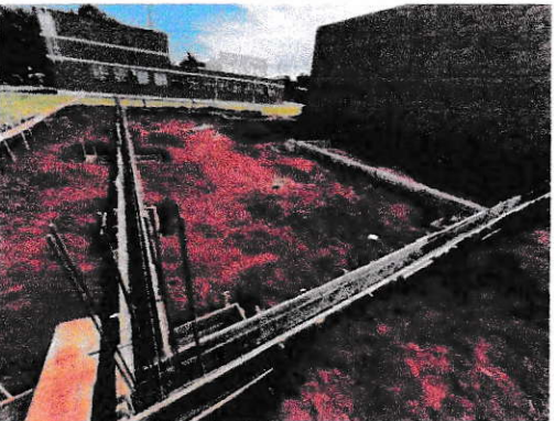
FÔRMA E ARMADURA — PILAR DE FUNDAÇÃO
