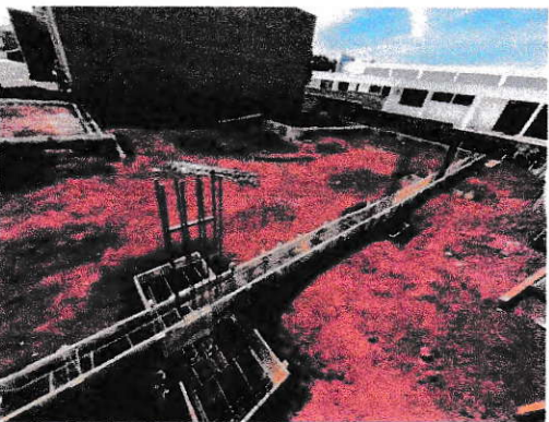
FÔRMA E ARMADURA — PILAR DE FUNDAÇÃO
