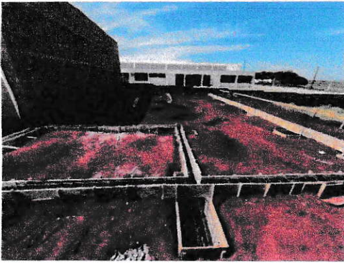
FÔRMA E ARMADURA — PILAR DE FUNDAÇÃO
