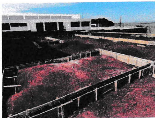
VISTA GERAL — FÔRMAS DE BALDRAME
