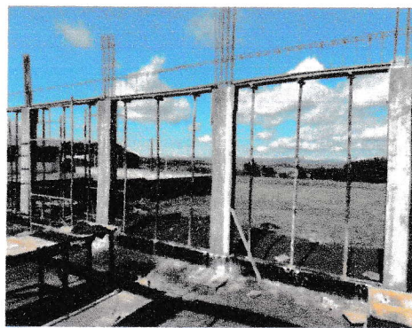
PILARES DO TÉRREO CONCRETADOS E ESCORAMENTO METÁLICO POSICIONADO PARA A FÔRMA DE VIGAS
