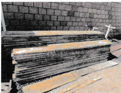
ESTOQUE DE MADEIRA DE FÔRMA DESTINADO ÀS VIGAS E LAJE — ETAPA SUBSEQUENTE
