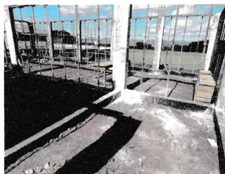
CONJUNTO DE BALDRAMES E PILARES DE FUNDAÇÃO CONCRETADOS, COM ARMADURAS DE ESPERA
