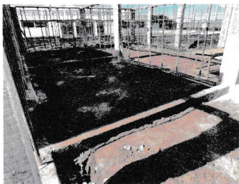
BALDRAMES DA AMPLIAÇÃO CONCRETADOS, DEFININDO OS AMBIENTES; IMPERMEABILIZAÇÃO EXECUTADA NA BASE
