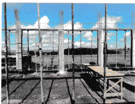
INÍCIO DA MONTAGEM DA FÔRMA DE VIGAS NO NÍVEL SUPERIOR; PISO INTERNO AINDA EM SOLO (LAJE NÃO INICIADA)."
