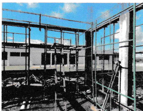
ANDAIMES MONTADOS E FÔRMA DE VIGA EM EXECUÇÃO; PILAR CONCRETADO
