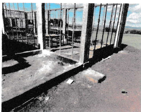
PILARES CONCRETADOS SOBRE BALDRAME IMPERMEABILIZADO; TRANSIÇÃO FUNDAÇÃO/SUPERESTRUTURA
