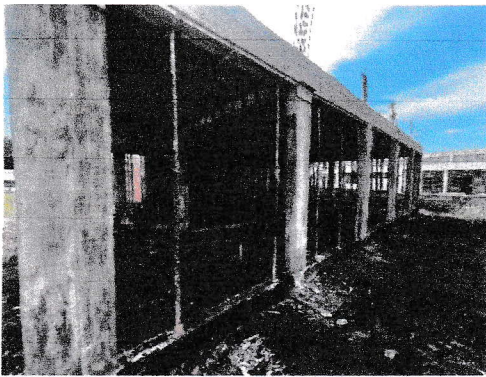
VISTA LATERAL DA ESTRUTURA CONCRETADA COM LAJE EXECUTADA E ESCORAMENTO.
