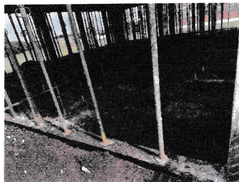
ESCORAMENTO METÁLICO E BALDRAMES SOB A LAJE CONCRETADA; AO FUNDO.
