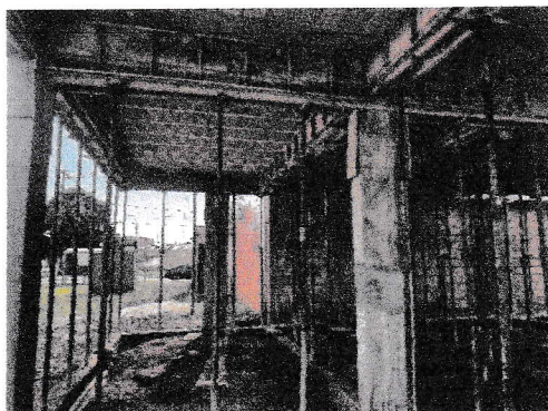
VISTA INFERIOR DA LAJE PRÉ-MOLDADA TRELIÇADA (ENCHIMENTO CERÂMICO E VIGOTAS), COM ESCORAMENTO E ALVENARIA DE VEDAÇÃO
