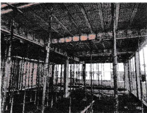
LAJE PRÉ-MOLDADA TRELIÇADA VISTA POR BAIXO — ENCHIMENTO CERÂMICO E VIGAS, COM ESCORAMENTO.
