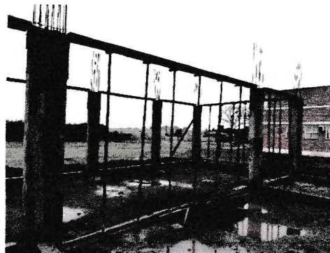
PILARES TÉRREO CONCRETADOS COM VIGAS ARMADAS NO TOPO
