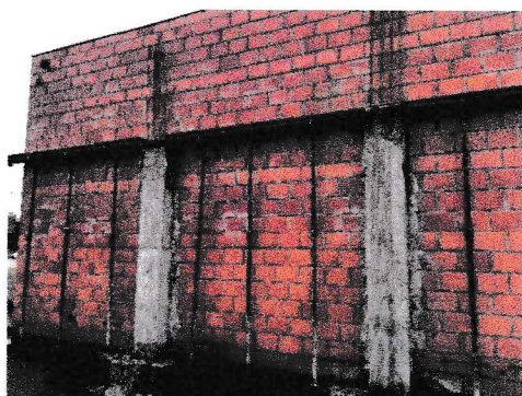
FACHADA — PILARES TÉRREO ENCOSTADOS NA EDIFICAÇÃO EXISTENTE
