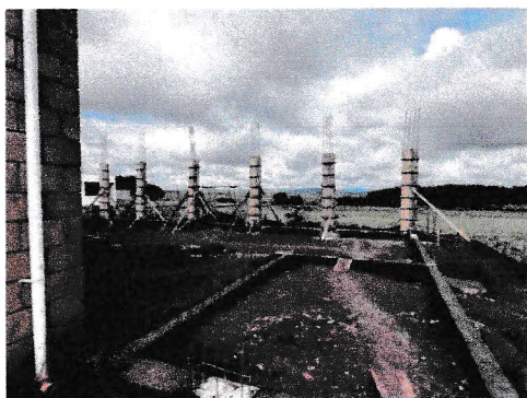
FÔRMAS DOS PILARES TÉRREO MONTADAS — VISTA GERAL
