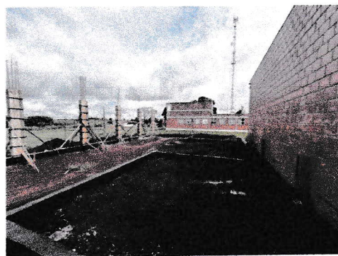
ARMADURAS DE VIGAS ESTOCADAS NO CANTEIRO — PRÓXIMA ETAPA
