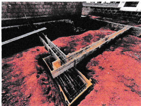
FÔRMA DE VIGA BALDRAME COM ARMADURA INTERNA — CA-50 16mm E 6,3m
