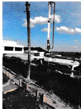
CONCRETAGEM DA FUNDAÇÃO — CAMINHÃO-BOMBA ENGEMIX
