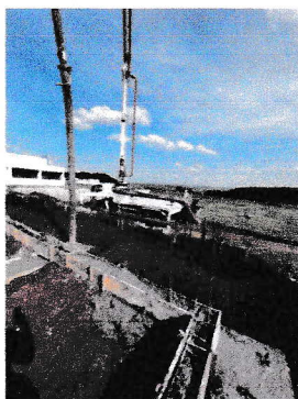
CONCRETAGEM DOS BLOCOS E BALDRAMES — EM EXECUÇÃO
