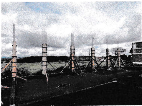
PILARES TÉRREO ESCORADOS SOBRE FUNDAÇÃO CONCLUÍDA
