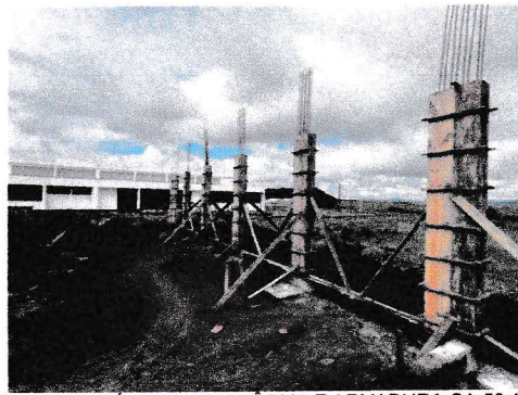
DETALHE — PILAR TÉRREO COM FÔRMA E ARMADURA CA-50 10mm 5mm
